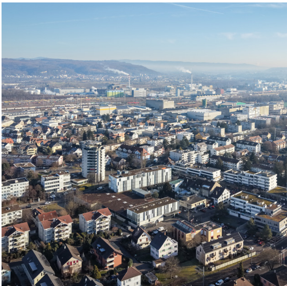
Vue aérienne de la partie orientale de MuttENZ, qui doit être alimentée par le réseau de chaleur d'ADEV.
