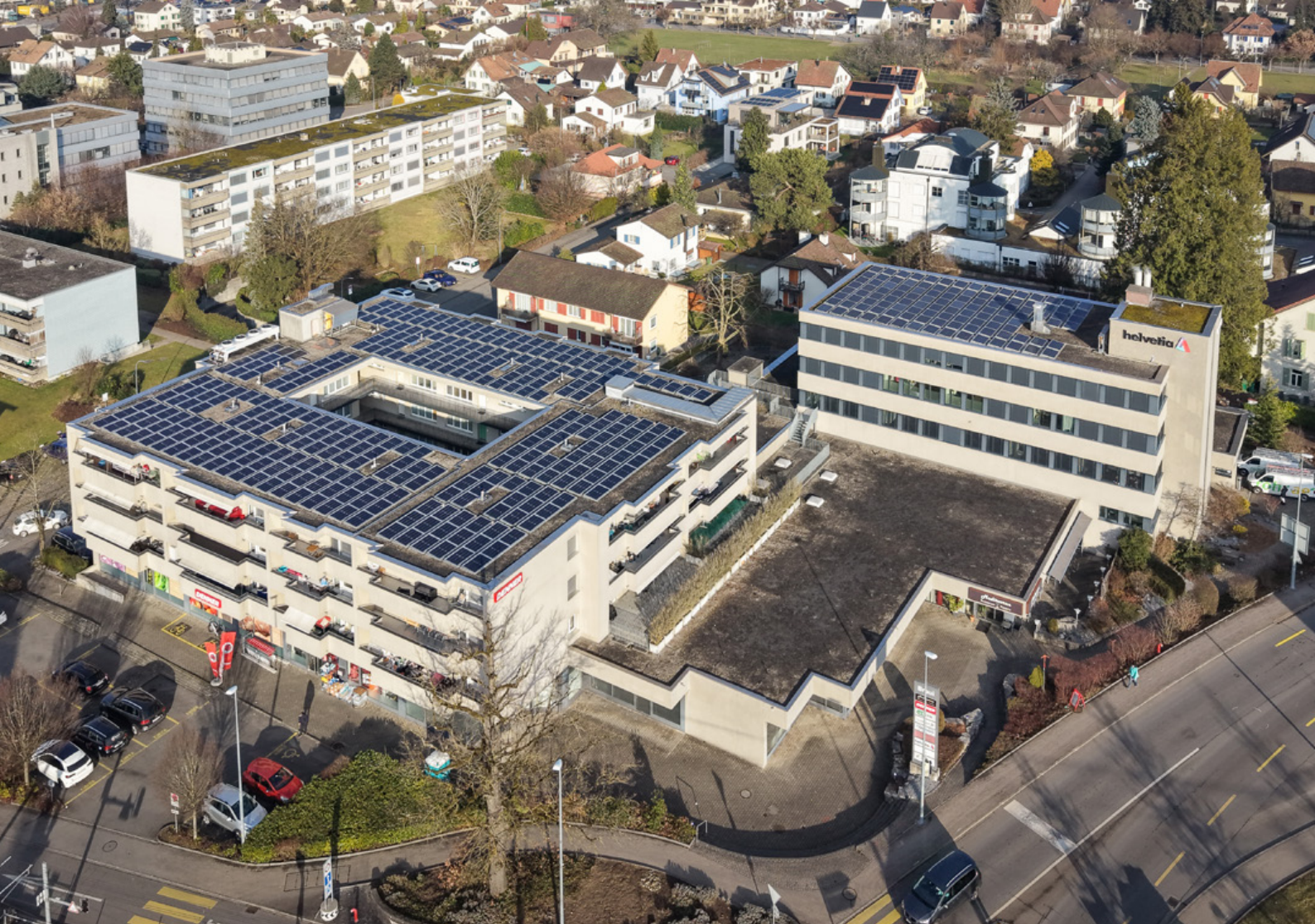
Le complexe « Braui » à Buchs : dans le cadre de la rénovation, la part de consommation propre a considérablement augmenté.
