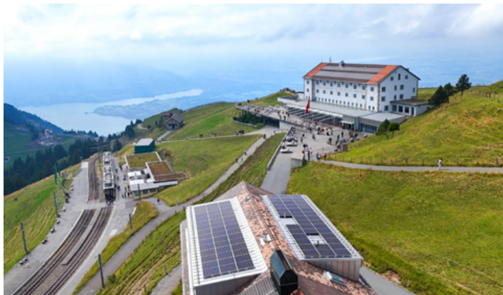
Au premier plan : la nouvelle installation ADEV.
