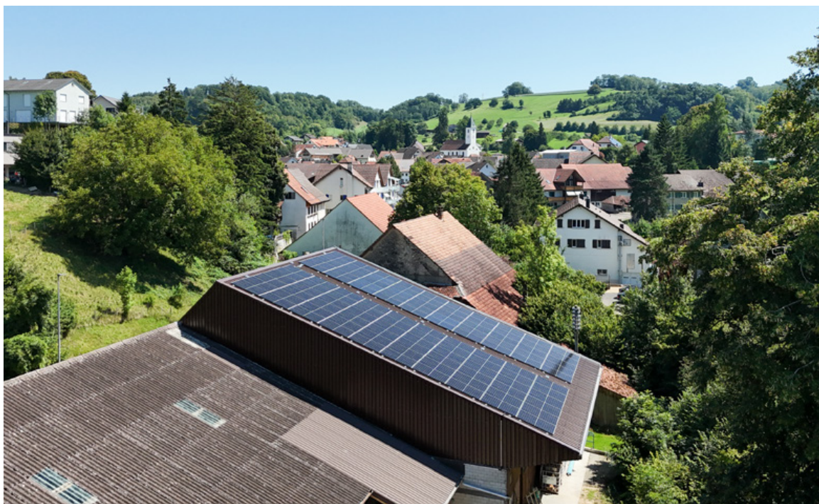
Au premier plan, la nouvelle installation sur le toit de l'étable. La famille utilisatrice habite à l'autre bout du village (au fond à droite, non visible).
