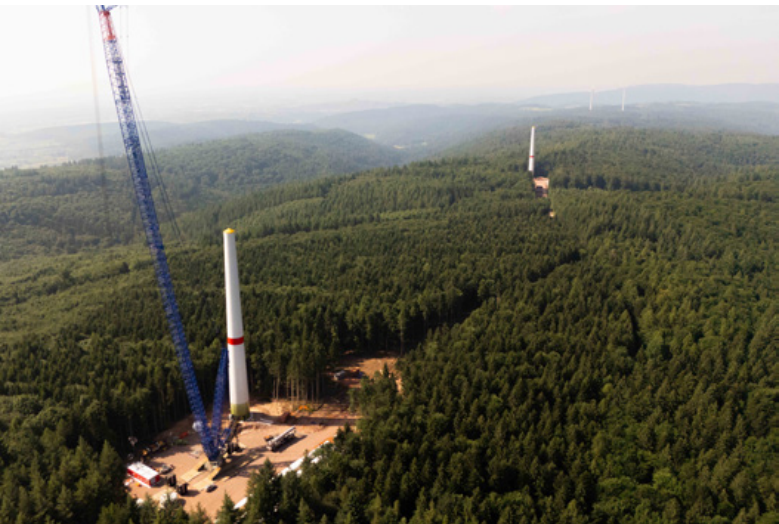
Le site de repowering d'Ettenheim/Kippenheim, où l'on élève la nouvelle ENERCON E-160.
