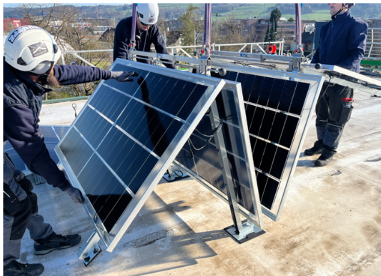
Après avoir hissé sur le toit à l'aide d'une grue les modules préassemblés, il ne reste plus qu'à les déplier et à les visser.
