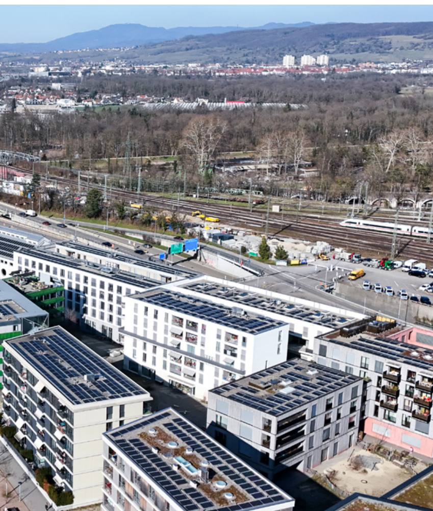
Erlenmatt Ost en mars 2025, avec les bâtiments en construction dans le prolongement du bâtiment vert.
