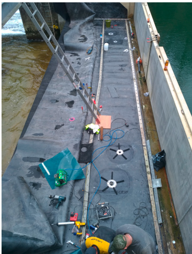
Installation du nouveau barrage gonflable
