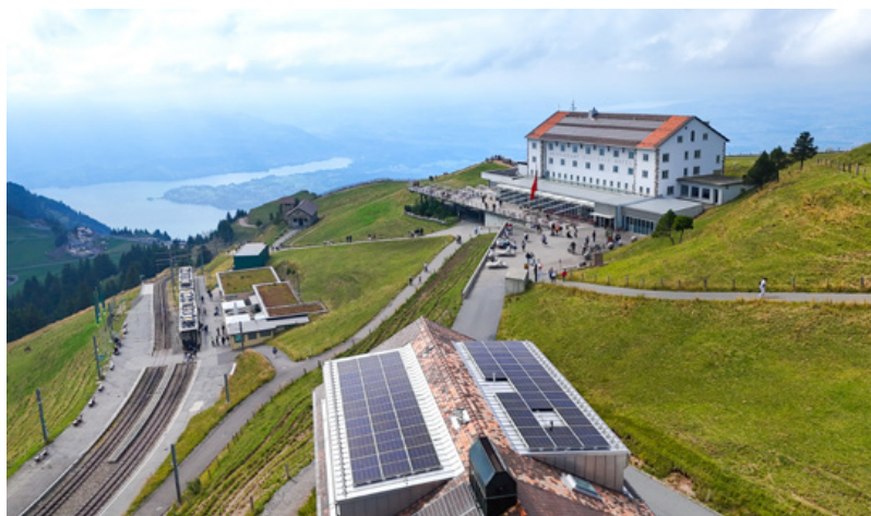
Im Vordergrund: Die neue ADEV-Anlage.
