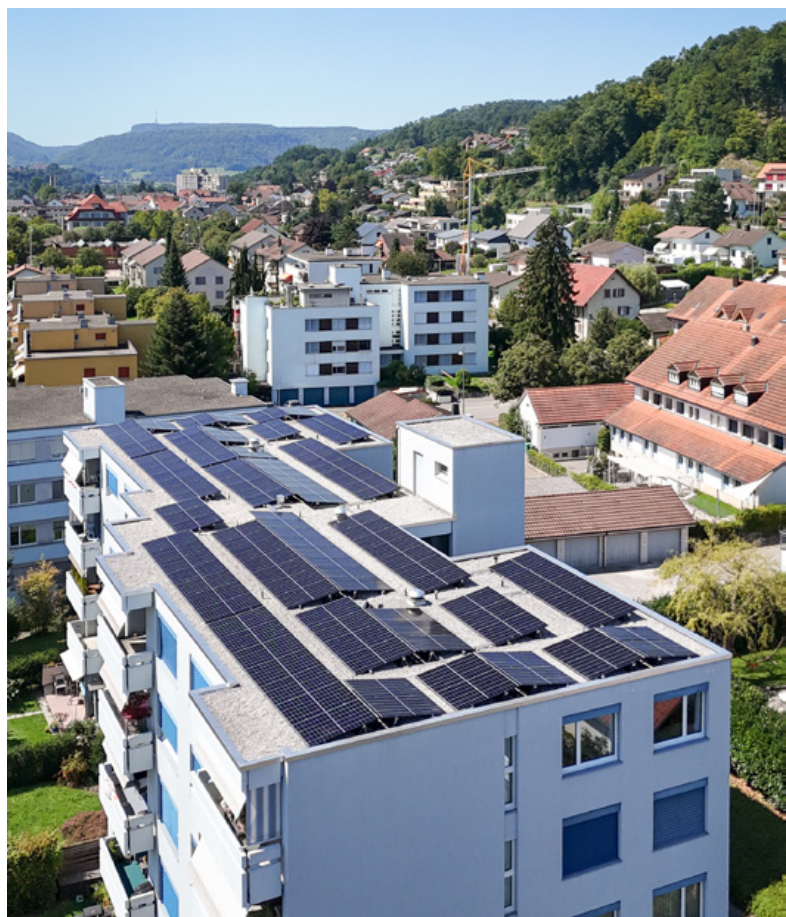
Luftaufnahme der Anlage: Die spezielle Dachgeometrie stellte besondere Anforderungen an die Layoutplanung.
