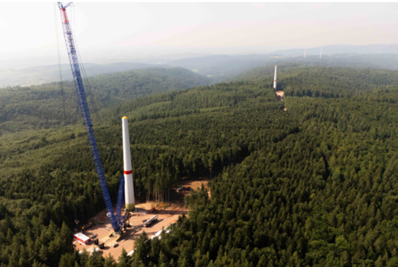
Am Repowering-Standort Ettenheim/Kippenheim wächst die neue ENERCON E-160 in die Höhe.
