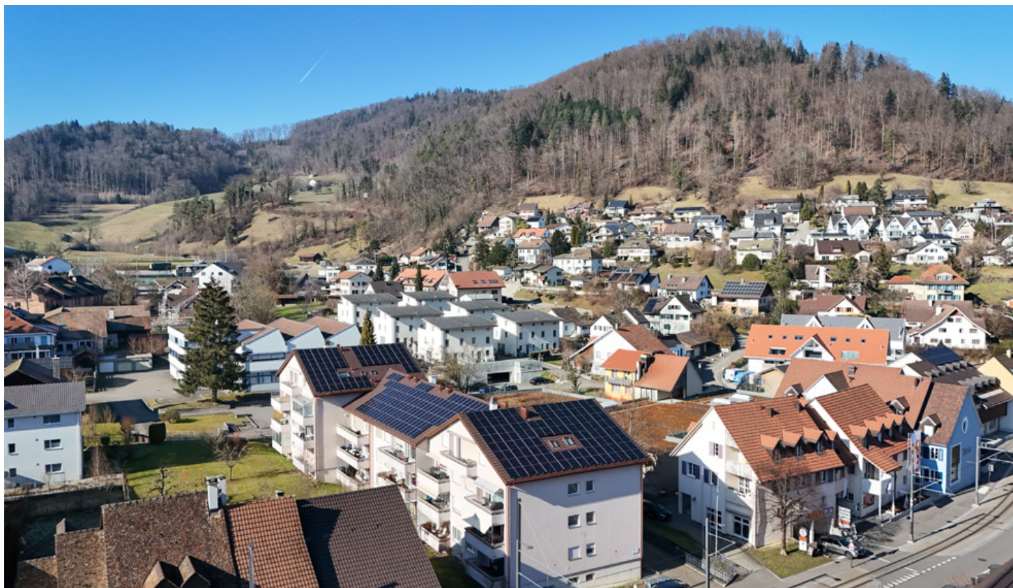
Die Solaranlage wurde auf verschiedenen geneigten Dächern montiert.
