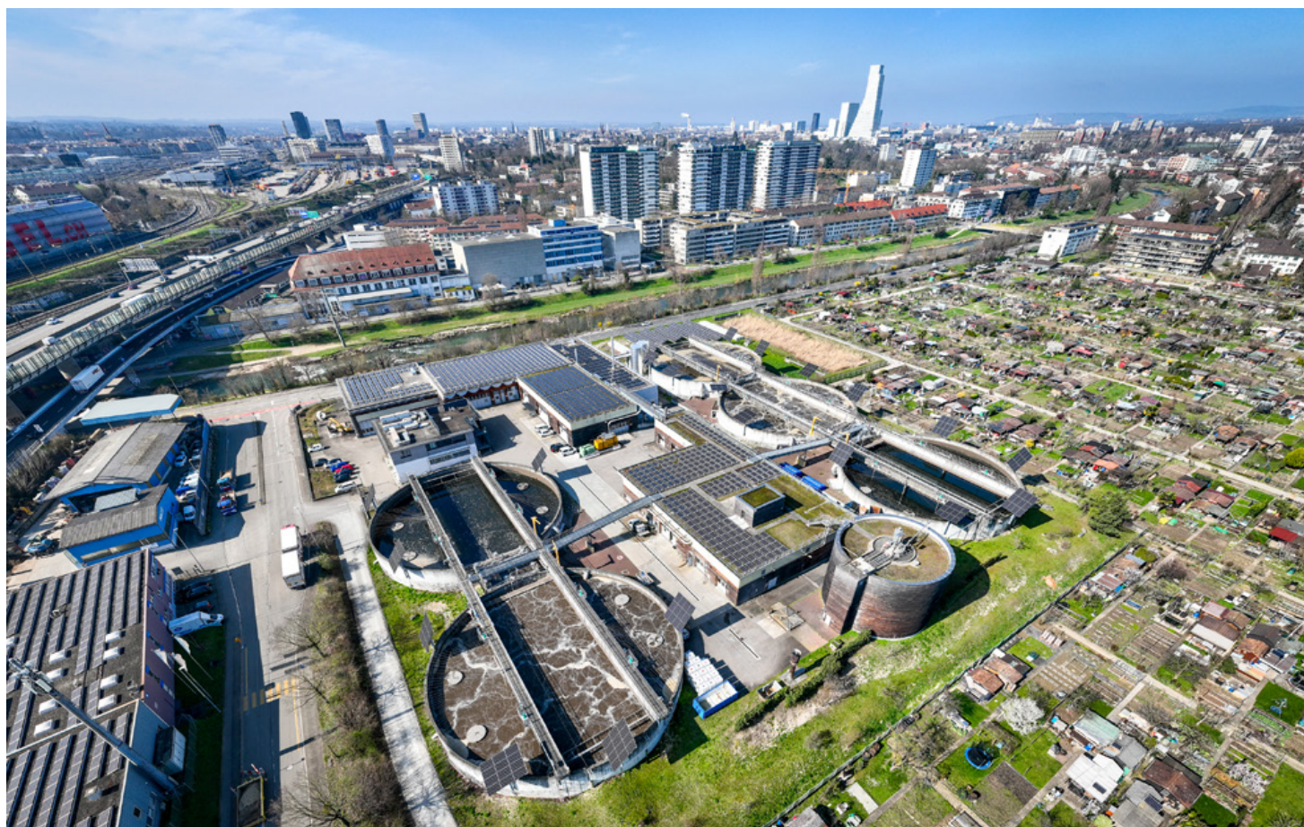
ARA Birs und das Lehenmatt-Quartier, welches nun Meter für Meter mit Fernwärme erschlossen wird.
