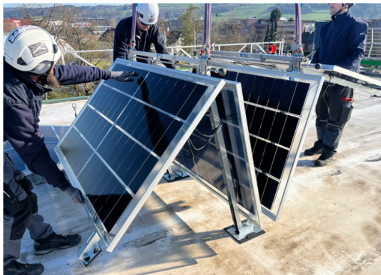
Die fertigen Module werden mit einem Kran aufs Dach gehoben und müssen dort nur noch aufgeklappt und festgeschraubt werden.
