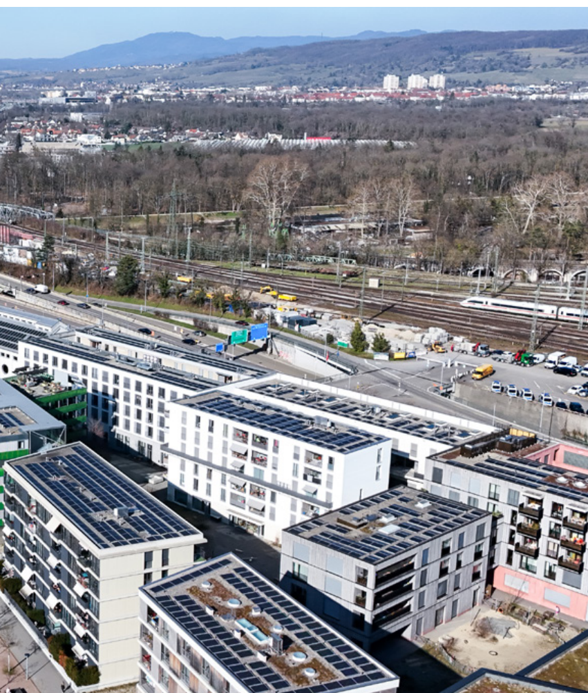
Erlenmatt Ost im März 2025. Hinten die im Bau befindlichen neuen Gebäude.
