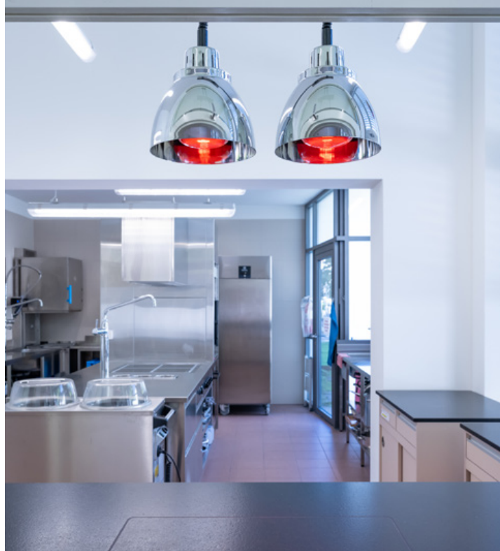
Hinter den Armaturen: Sauber verlegte Anschlüsse der Willy Gysin AG.
