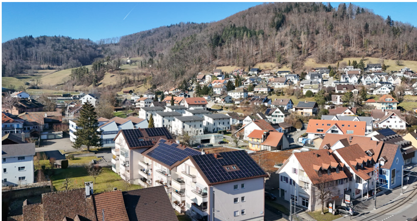
L'installation solaire a été montée sur des toits à différentes pentes.
