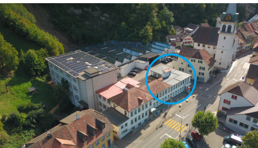
La nouvelle centrale sera installée dans un bâtiment (cercle) de l'entreprise Tschudin+Heid AG.
