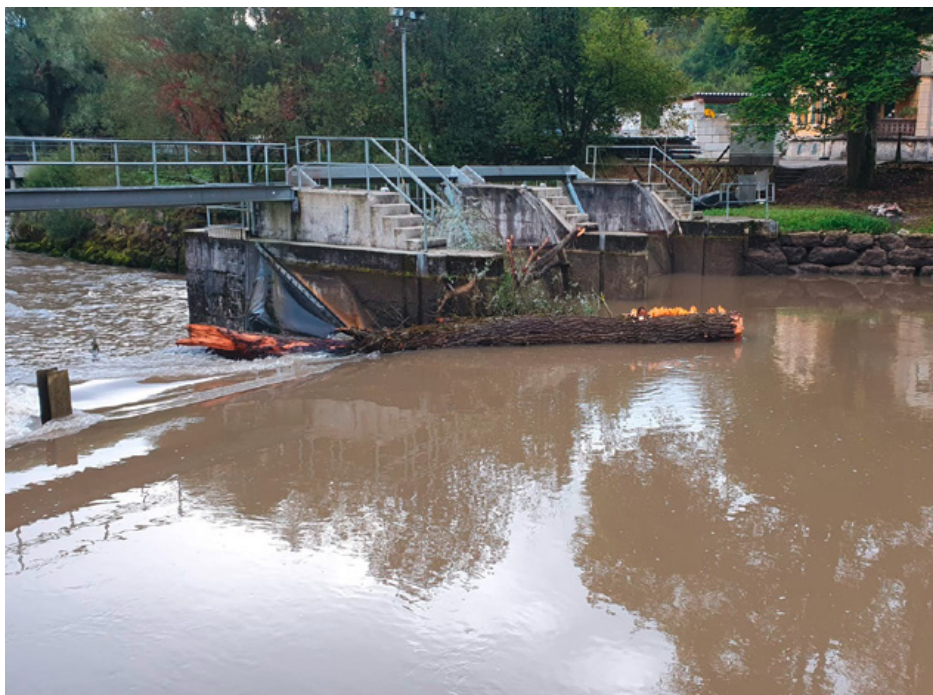
Le tronc qui a vraisemblablement endommagé le barrage.
