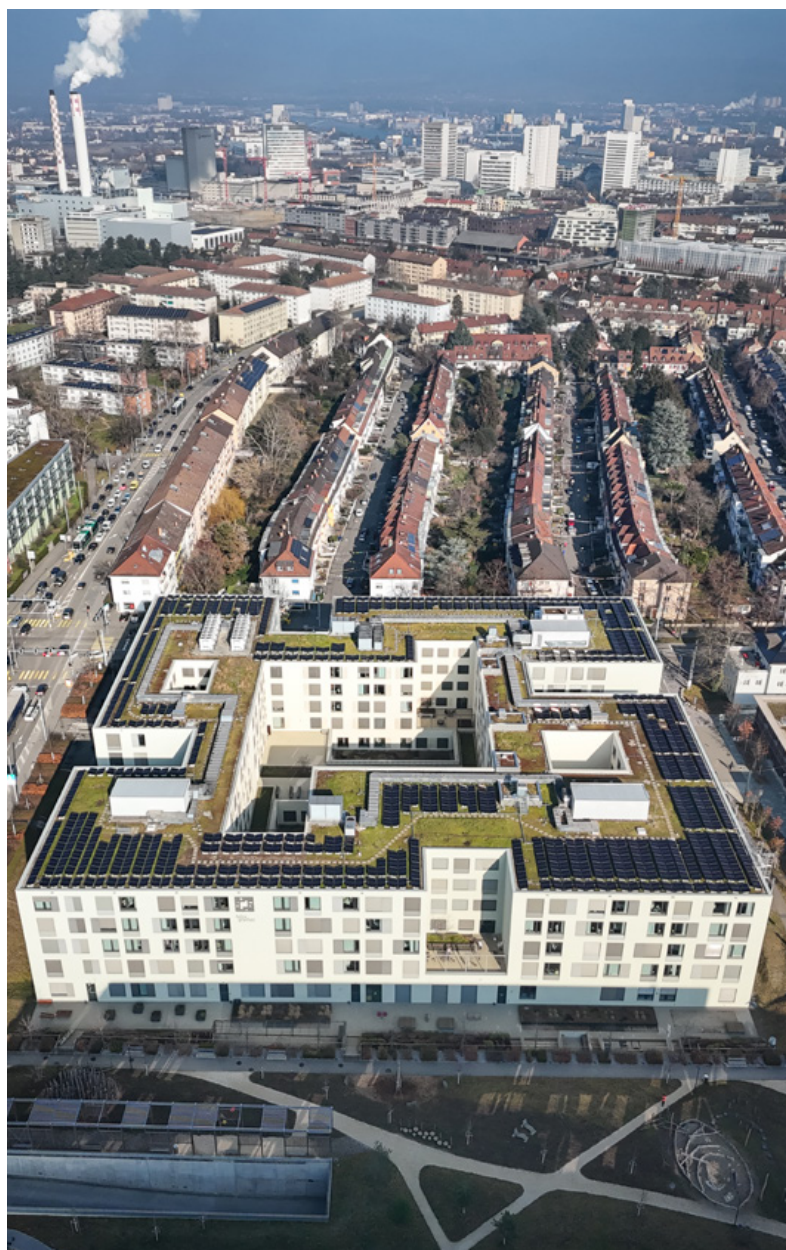
Bien visible à vue d'oiseau : la disposition astucieuse des modules sur le toit du nouveau bâtiment de l'hôpital.
