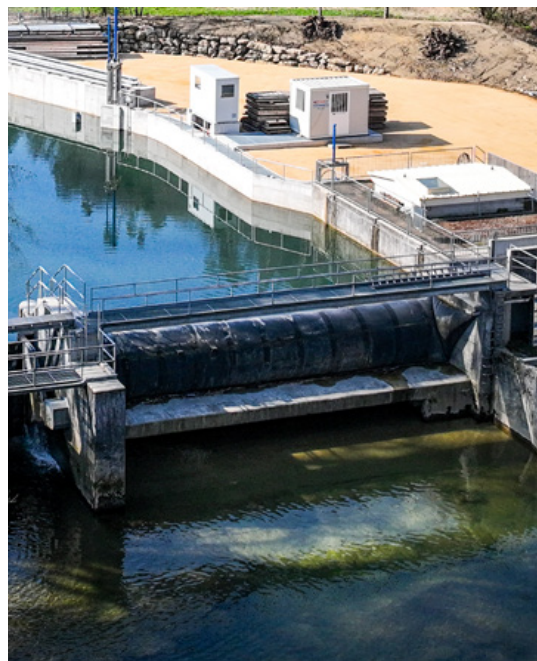
Vue du barrage gonflable peu après sa rénovation au printemps 2024.
