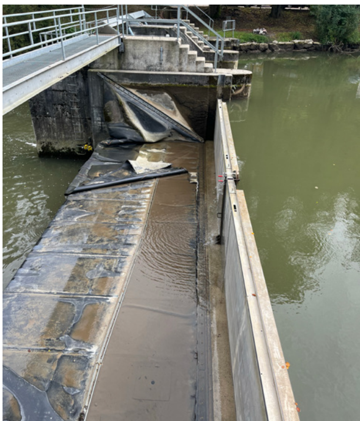
Le batardeau est un peu moins haut que le barrage original.
