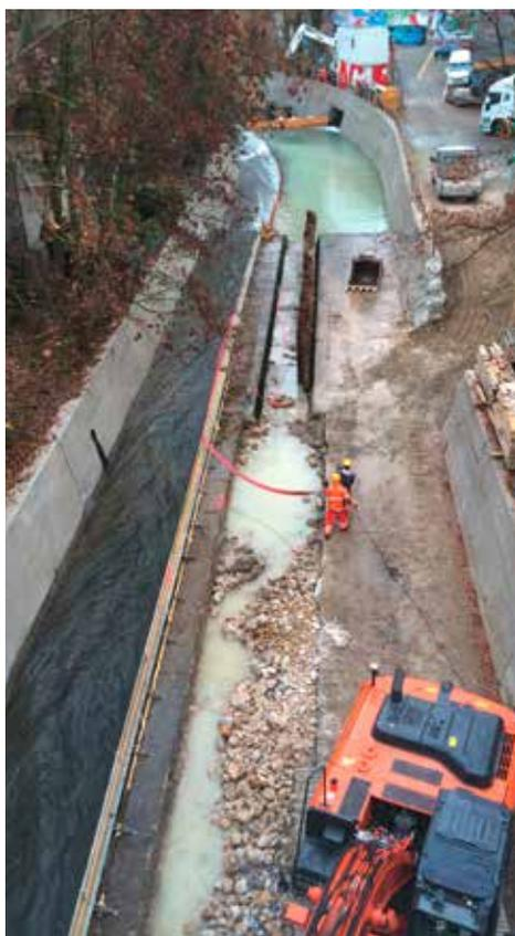
Unmittelbar beim Regionalbahnhof Hammer im Zentrum von Olten wird im Betonkanal der Dünnern ab 2016 Strom für 400 Oltener Haushalte produziert.
