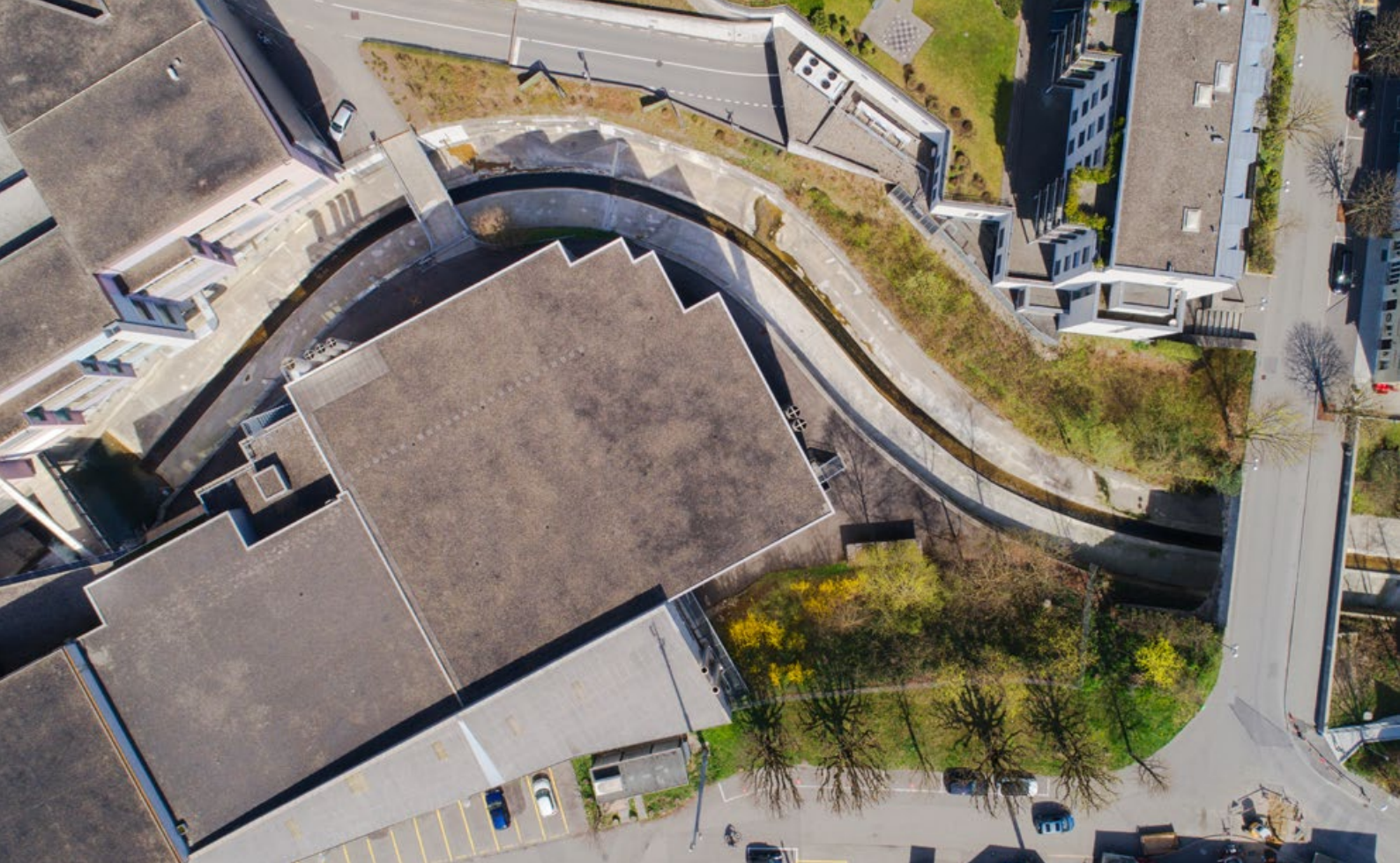
La canalisation bétonnée de la rivière Dünnern, à Olten, est désormais utilisée pour produire de l'électricité grâce aux efforts d'ADEV Wasserkraftwerk AG.
