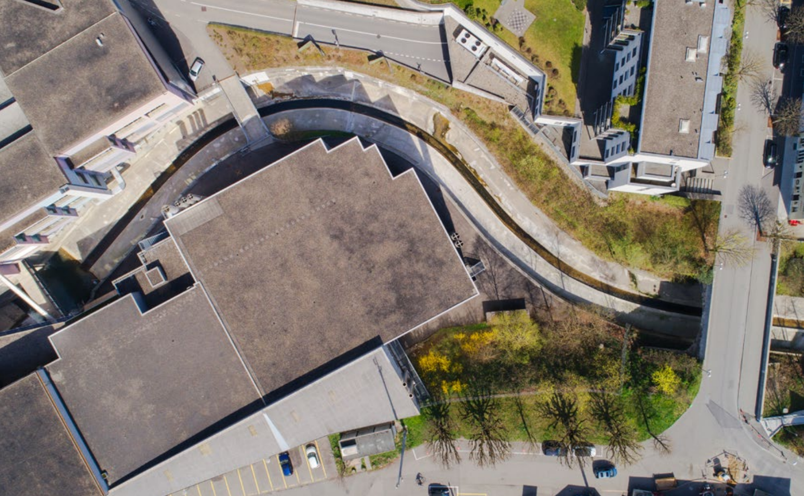
Der bestehende Betonkanal des Bachs Dünern in Olten, der dank dem Engagement der ADEV Wasserkraftwerk AG nun auch für die Stromproduktion genutzt wird.
