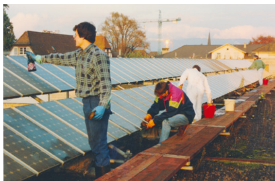
1993 : nettoyage des panneaux solaires sur le bâtiment de la gare de Rheinfelden.
