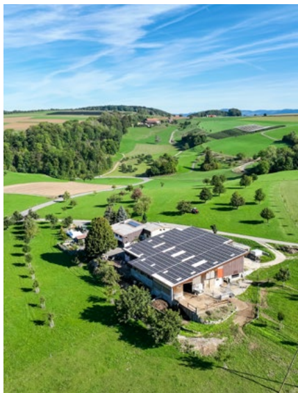
L'installation photovoltaïque, entièrement rénovée en 2022, du Bäumlhof, à Buus (BL).
