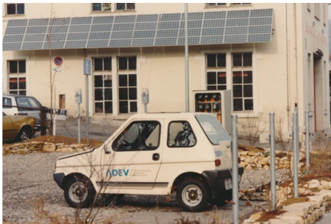
1989 : l'installation PV Park+Ride à la gare de Liestal.
