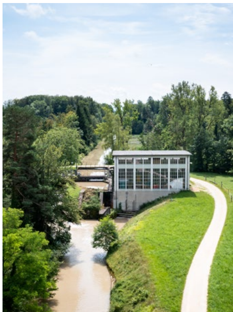
La centrale hydroélectrique de Moosbrunnen 1, construite en 2014 sur l'Emme près d'Utzenstorf (BE).
