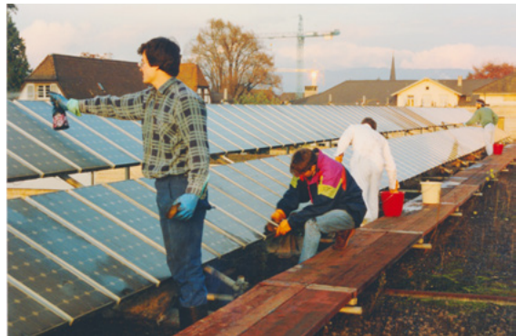
1993: Reinigung der Solaranlage auf dem Bahnhofsgebäude Rheinfelden.
