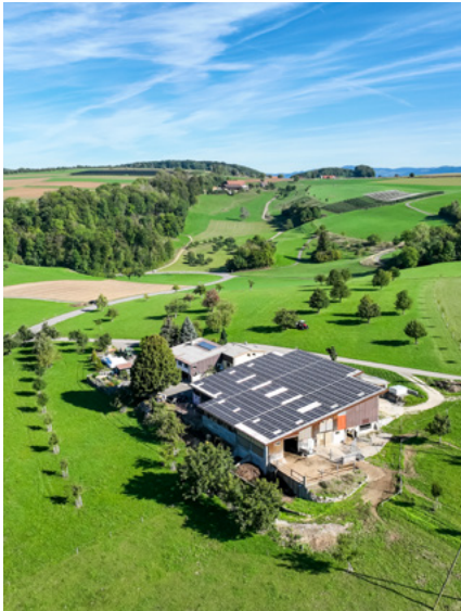
Die 2022 rundum erneuerte Photovoltaik-anlage auf dem Bäumlhof in Buus (BL).
