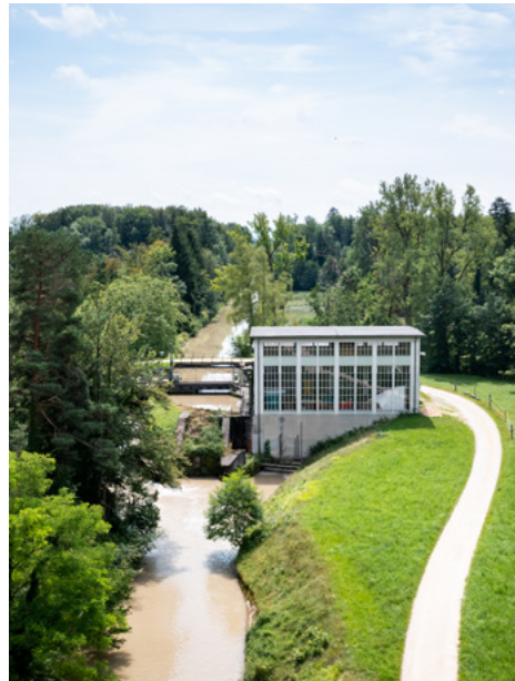
Das 2014 erstellte Wasserkraftwerk Moosbrunnen 1 an der Emme in der Nähe von Utzenstorf (BE).
