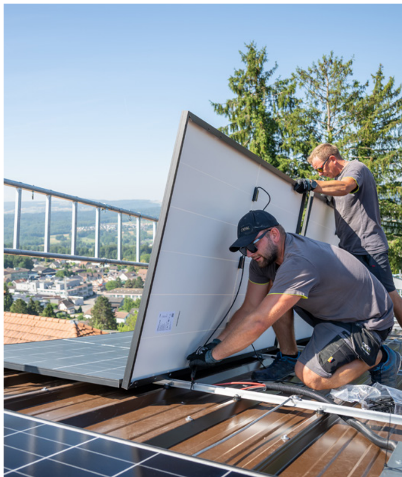
Module après module, l'installation solaire prend forme sur le toit du nouveau bâtiment rural.
