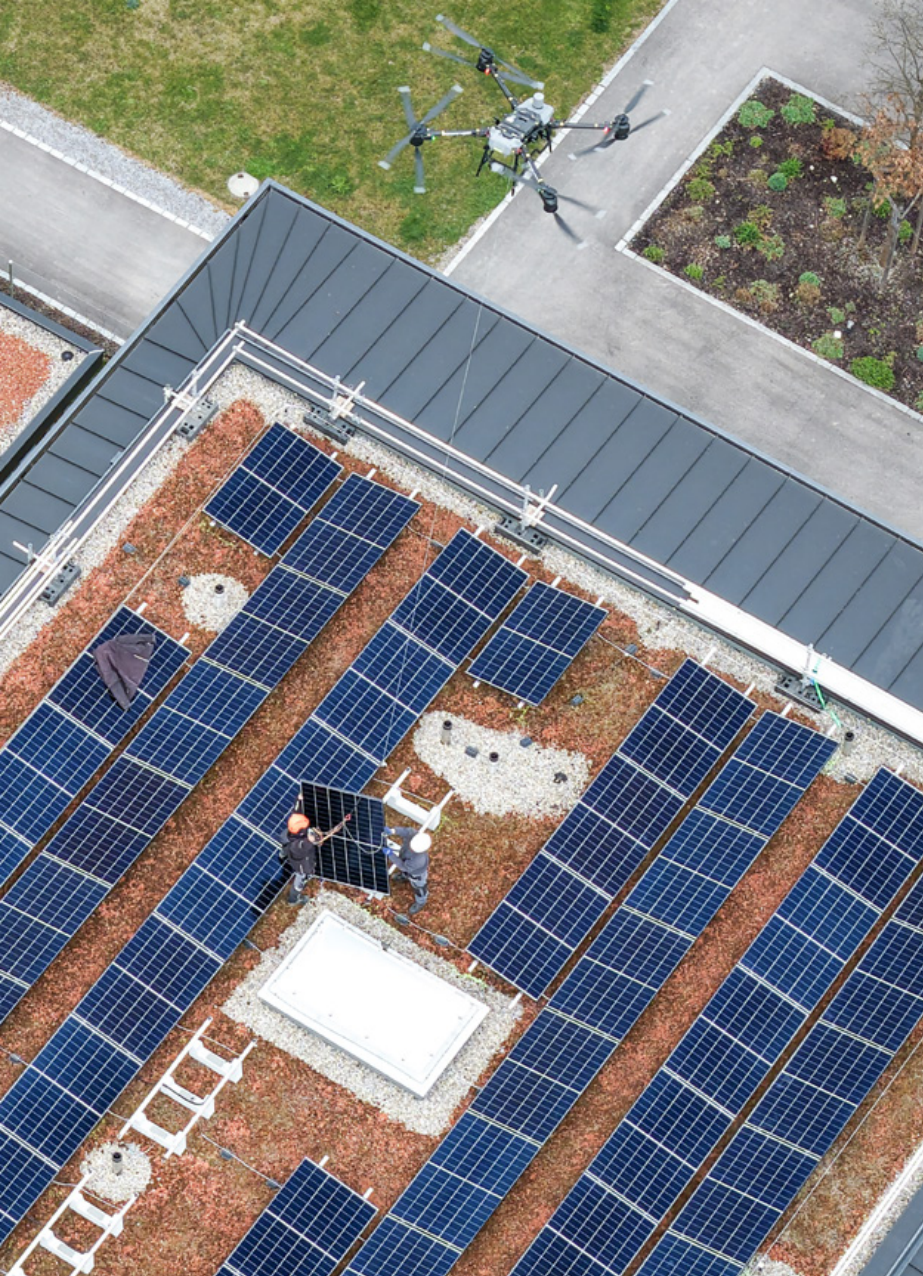
Le drone de transport dépose chaque module avec précision sur la sous-structure.
