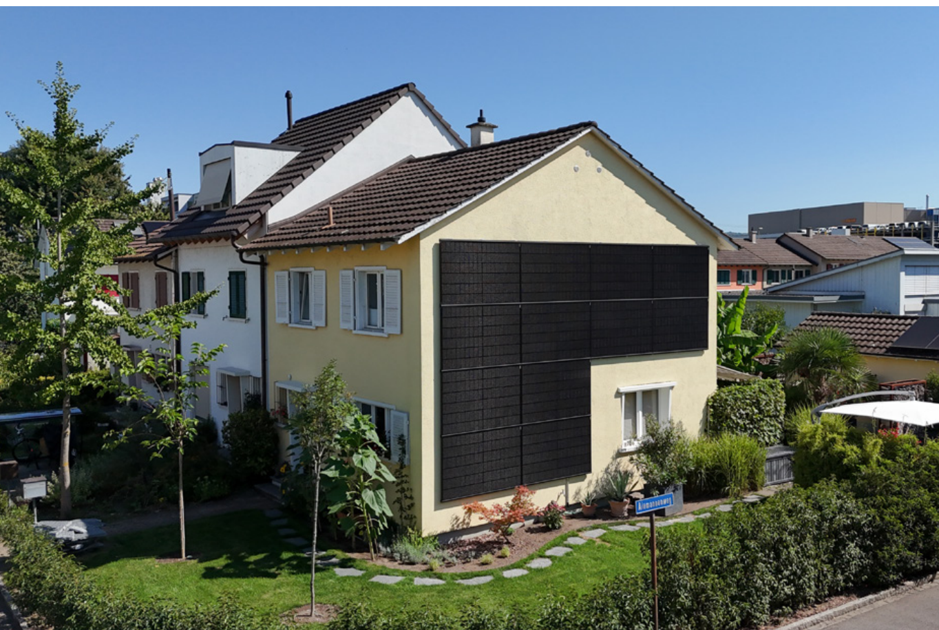
Die Südfassade bietet Platz für 24 Quadratmeter Solarmodule.
