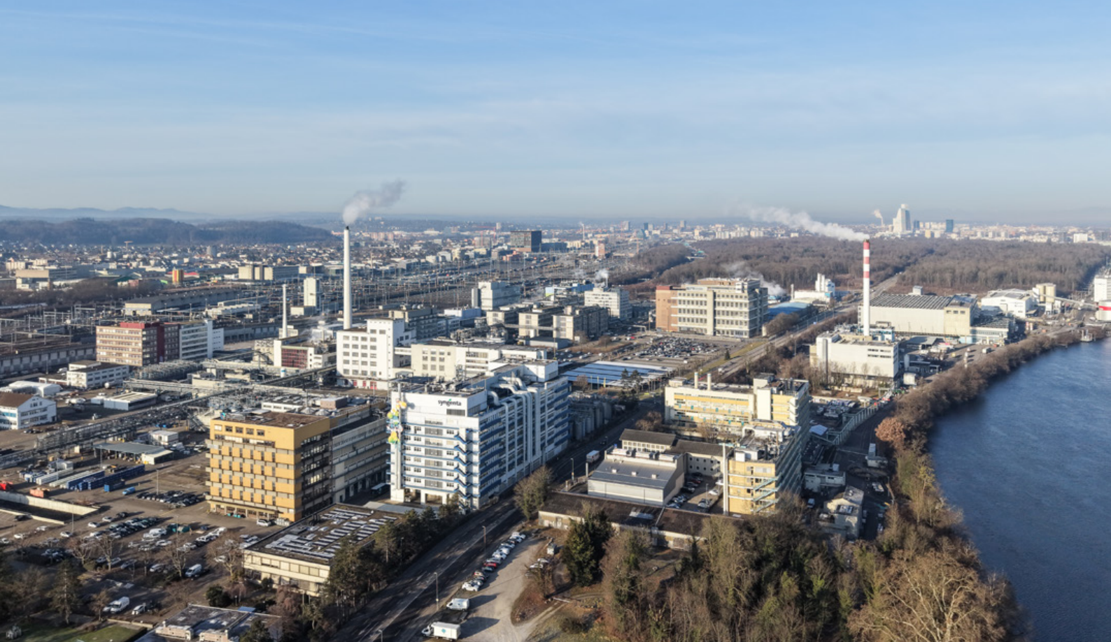
Auf dem GETEC-Areal entstehen rund 700 Gigawattstunden Abwärme pro Jahr.
