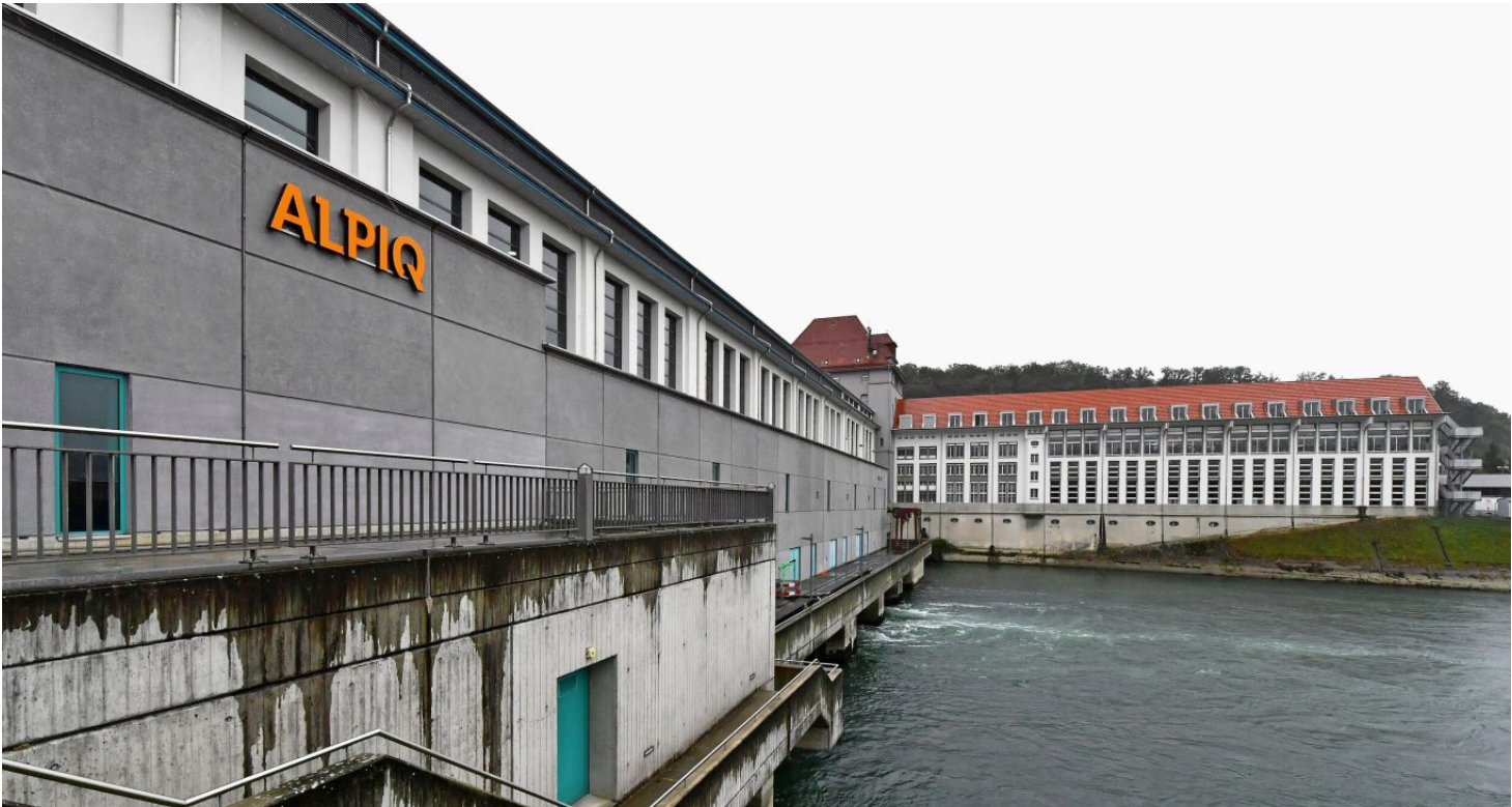
Das Wasserkraftwerk der Alpiq Hydro Aare AG bei Niedergösgen produziert derzeit weniger Strom.
