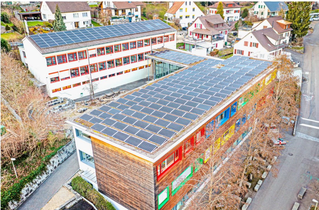
Die Adev betreibt mehrere grosse PV-Anlagen, wie diese auf dem Niederdörfer Schulhaus. Bild Adev/Lukas Pitsch
