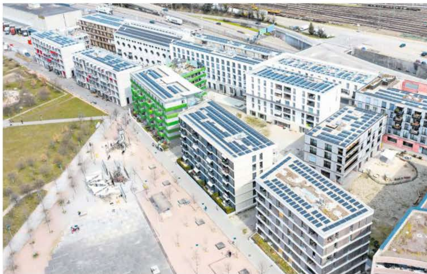
Auf den elf Gebäuden im Erlenmatt-Ost-Quartier befindet sich die in der Region grösste Anlage der Adev.
