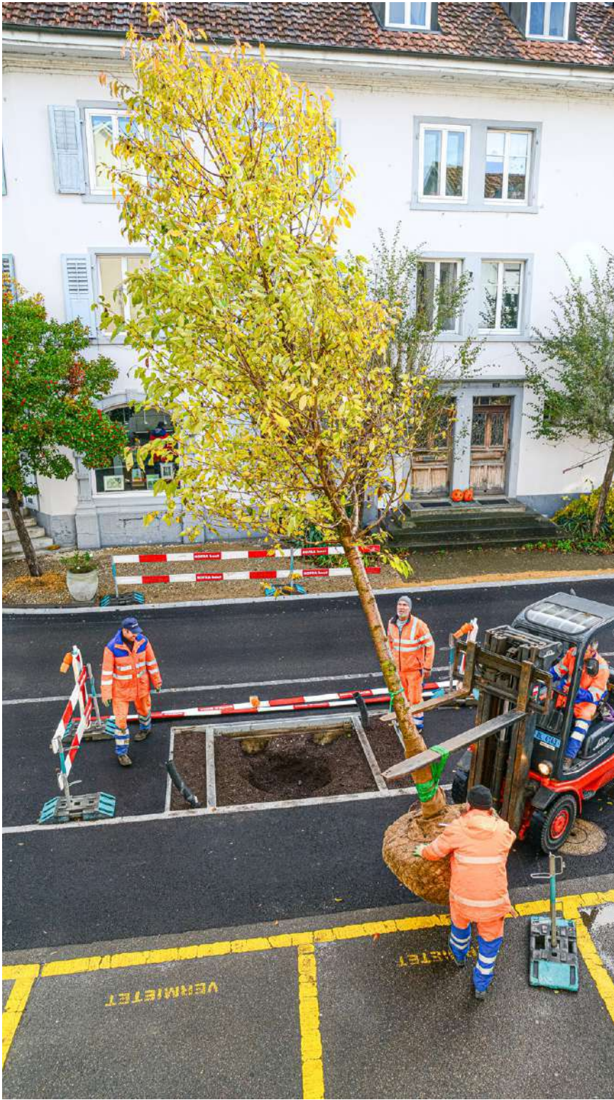
Das Pflanzen eines Baums mit speicherfähiger Pflanzenkohle unter dem Strassenbelag kostet rund 35 000 Franken. Bild Christian Horisberger
