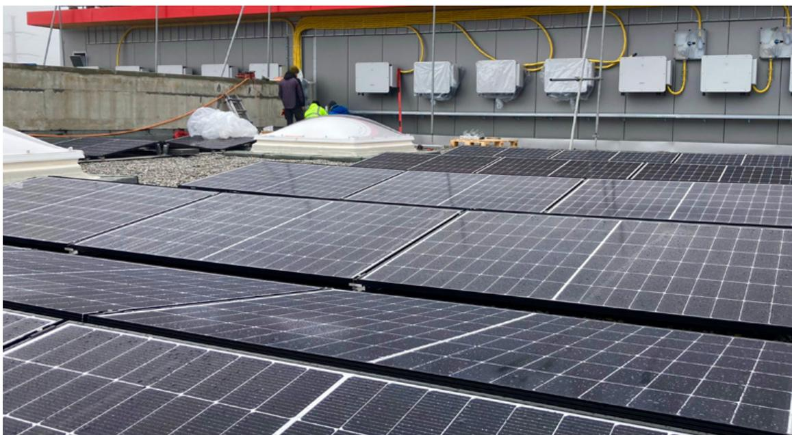
Bereits montierte Solarmodule auf dem Dach des Gewerbeparks. An der Wand sind die zwölf Wechselrichter der Anlage befestigt.
