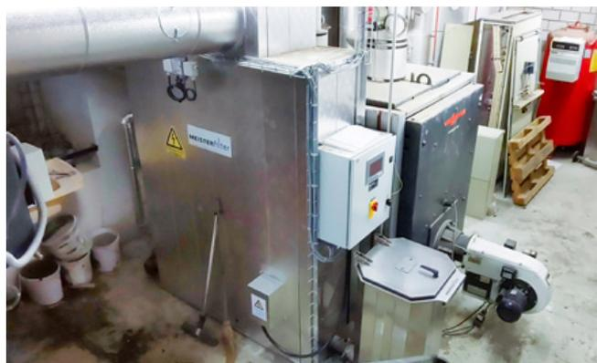
Blick in die Zentrale Emmenau mit dem neu eingebauten Filter in der Bildmitte (Meisterfilter)
