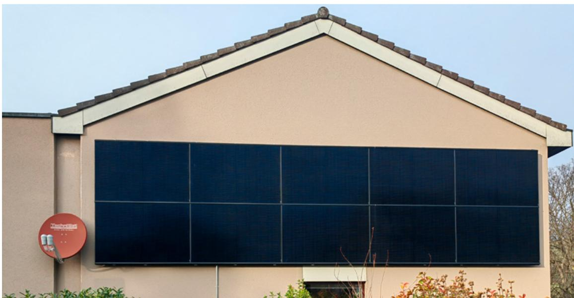
Die Module an der Südfassade produzieren genügend Strom, um das Einfamilienhaus zu versorgen.
