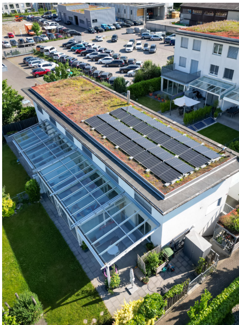
Rund um die Aufdach-Anlage sieht man die Betonblöcke, welche die Anlage beschweren.
